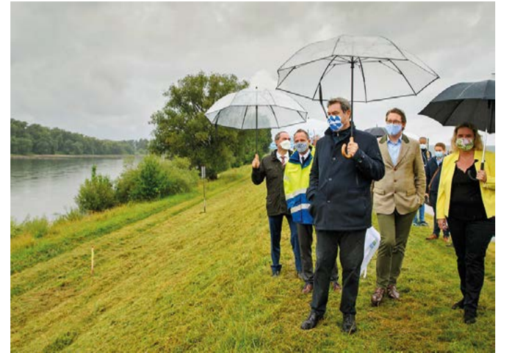
V.l.: Wirtschaftsminister Hubert Aiwanger, Umweltminister Thorsten Glauber, Ministerpräsident Dr. Markus Söder, Bundesverkehrsminister Andreas Scheuer und Verkehrsministerin Kerstin Schreyer im Baustellenbereich des Polders Sulzbach am Deich Waltendorf.
