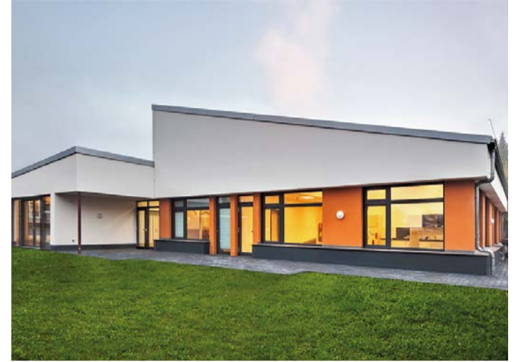
Der Anbau der Kindertagesstätte wurde aus ökologischen Ziegel-Holz-Hybridbaustoffen errichtet. Diese schaffen beste Voraussetzungen für ein wohngesundes Umfeld. Bild: UNIPOR /München
