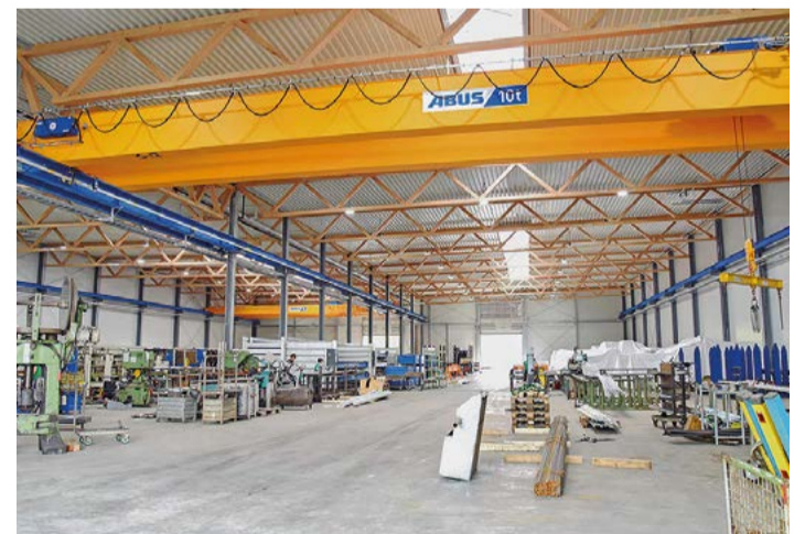
Die Fertigungshalle in der Innenansicht. Bild: Rudolf Hörmann GmbH & Co. KG
