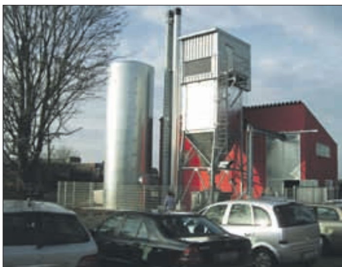
Klimaschutz durch Kohlendioxideinsparung beim neuen Biomasseheizkraftwerk in Günzburg. Text und Bild: Hans Joas
