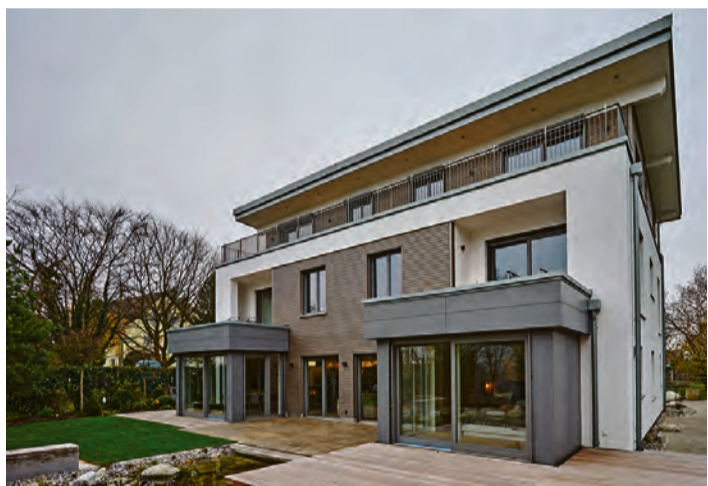
Die Gütesicherung im Holzbau betrifft neben Ein- und Zweifamilienhäusern auch den mehrgeschossigen Holzbau. Foto: BMF/Sonnleitner Holzbauwerke
