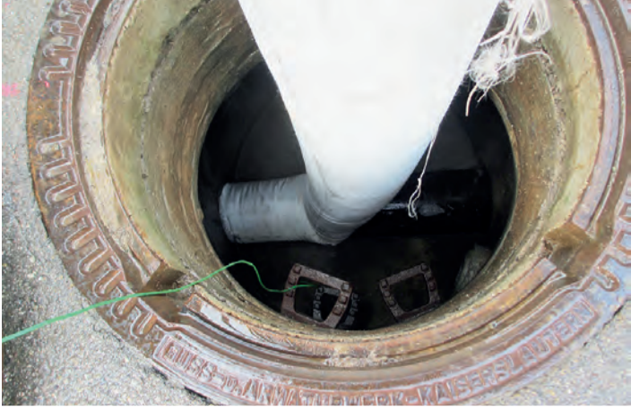
Einbringen des Schlauches über den Schacht in die Haltung. Das grüne Kabel dient zur Übertragung der Temperaturwerte an das Datenaufzeichnungsgerät.
