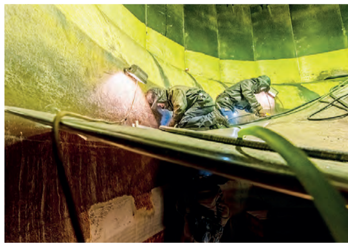
Arbeiten an der Turbine.
