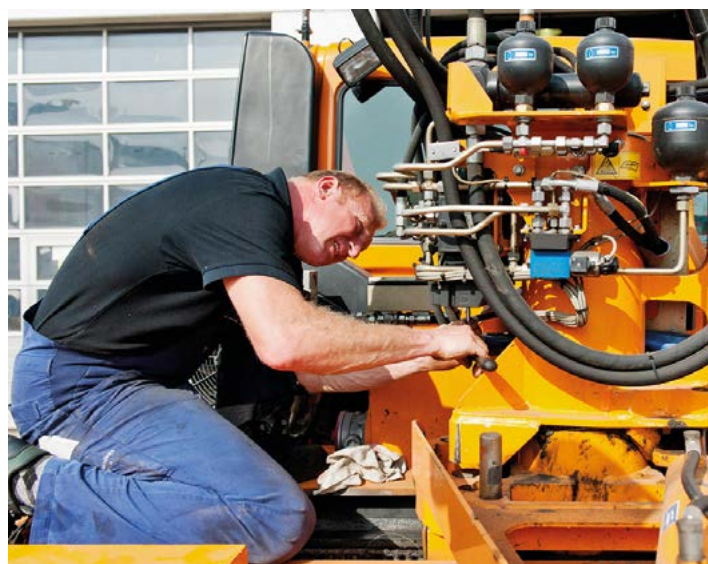
Monteur der Firma Beuthhauser
