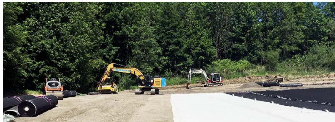
Einsatz von aufbereitetem PAK-haltigem Straßenaufbruch als Deponiersatzbaustoff.
