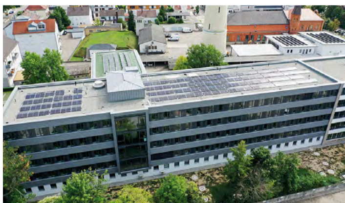
Photovoltaikanlage auf dem Dach des Landratsamtes.
