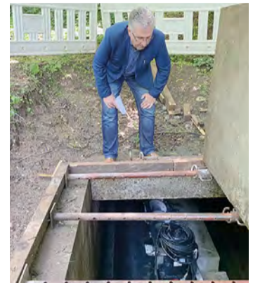
Erster Bürgermeister Kurt Krömer macht sich ein Bild von den Sanierungsarbeiten. Bild: Stadt Stein
