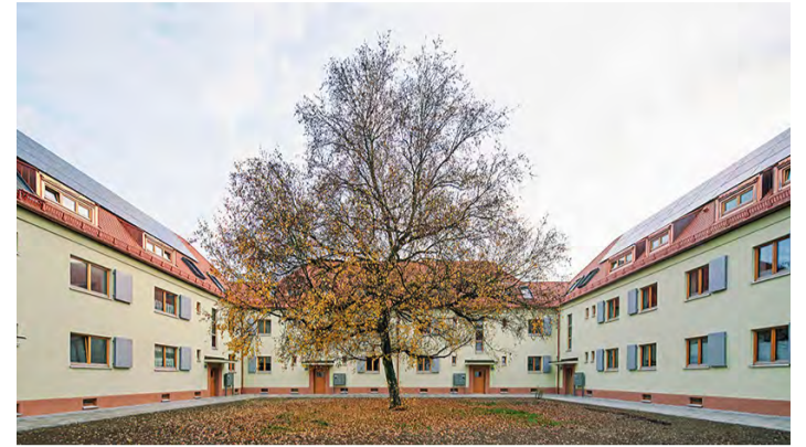
Die Sanierung der Regensburger Margaretenau gilt als Leuchtturmprojekt. Bild: Herbert Stolz
