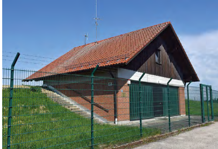
Der größte und älteste Hochbehälter des Staudenwasserzweckverbandes bei Siebnach wird im kommenden Winter generalsaniert. Bild: Walter Kleber
