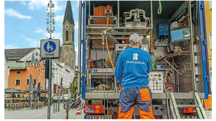
Reinigung, Inspektion und dreidimensionale Erfassung der Leitungsverläufe mit dem professionellen TV-Inspektionsfahrzeug der Fa. Pfaffinger Rohrnetz- & Sanierungstechnik GmbH. Bild: JT-elektronik GmbH
