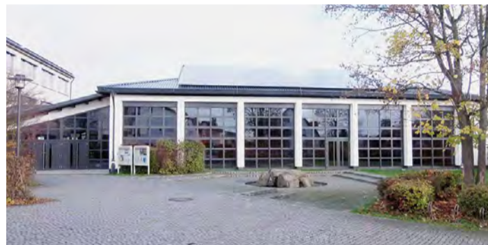
Die Photovoltaikanlage auf der Mehrzweckhalle in Fuchsmühl. Weitere Anlagen befinden sich auf dem Rathaus, Bauhof, Markthaus und auf dem Dach der Freiwilligen Feuerwehr. Bild: Markt Fuchsmühl
