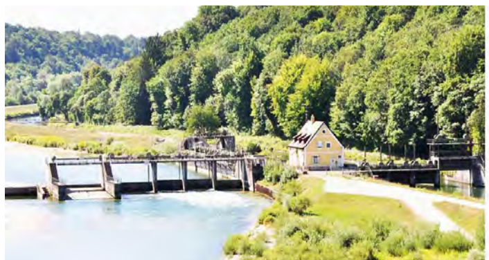
Das bisherige Großhesseloher Wehr und die Anlage nach dem Umbau mit der Fischtreppe (am Ufer rechts).
