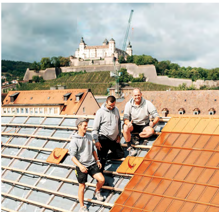
Würzburg: Dach des Klosters der Schwestern des Erlösers, Neueindeckung mit Solarmodulen.
