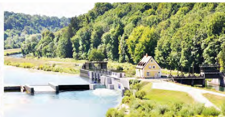
Das bisherige Großhesseloher Wehr und die Anlage nach dem Umbau mit der Fischtreppe (am Ufer rechts).
