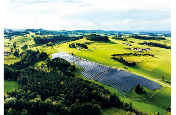
Von der Photovoltaik-Anlage im Markt Wiggensbach profitieren indirekt alle 5.000 Einwohner, da die Einnahmen in die Gemeindekasse fließen.
