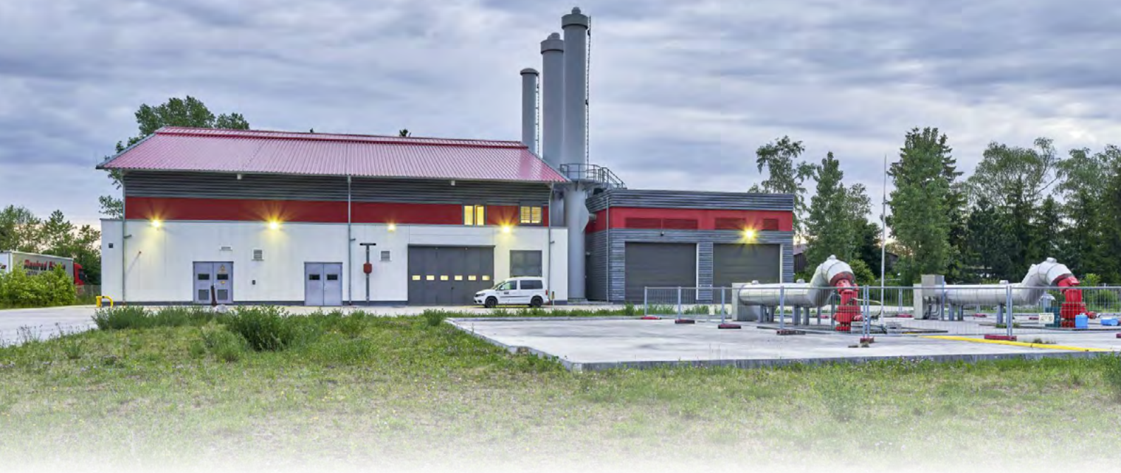
Energiezentrale der WVI GmbH &amp; Co.KG
