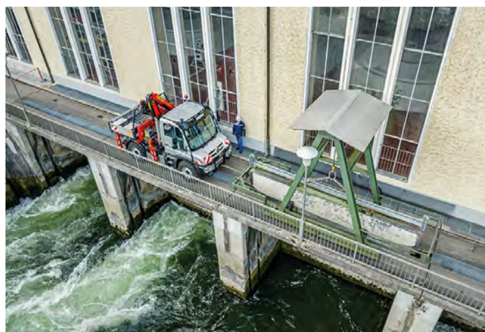
Der Unimog bei der Arbeit im Wasserkraftwerk.
