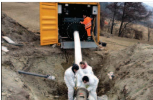
Mit der Drucktrommel wird der Liner in die zu sanierende Haltung invertiert. Bild: Diringer&Scheidel Rohrsanierung
