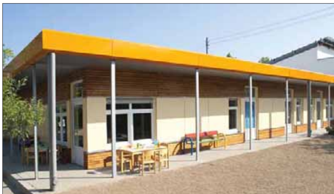
Die Modulbauten der Graeff Container GmbH: kurzfristig realisierbar, etatschonend und architektonisch anspruchsvoll. □
