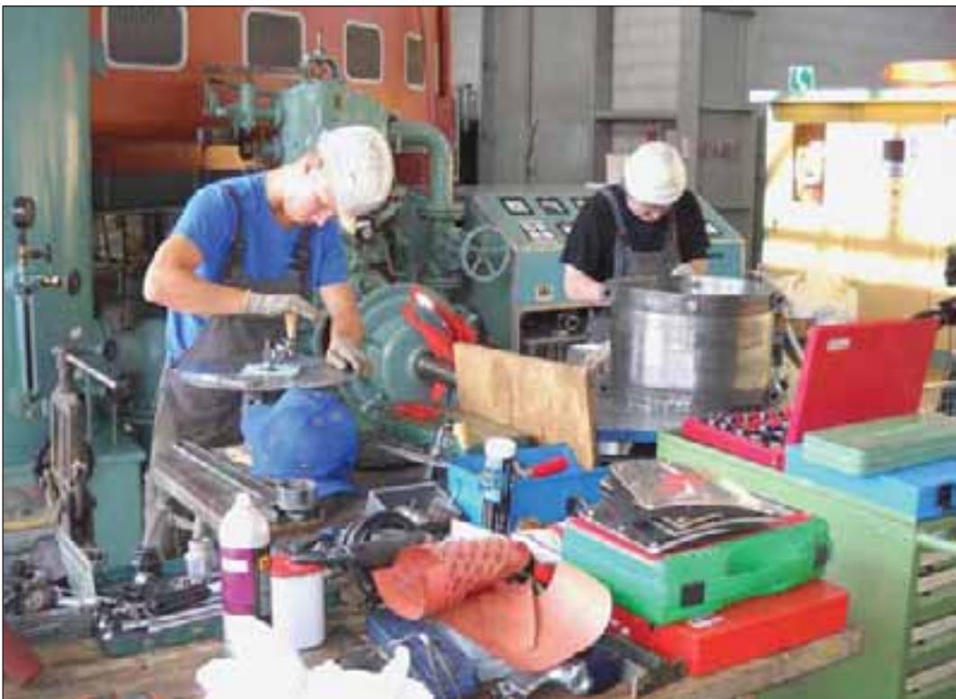
Mitarbeiter der E.ON legen letzte Hand an, um die Maschine 1 des Kraftwerk wieder voll einsatzbereit zu machen. Im Hintergrund der rote Generatorständer der Maschine 2 von 1932, der bereits seit 2011 wieder umweltfreundlichen Strom aus Wasserkraft erzeugt. Bild: Jan Kiver
