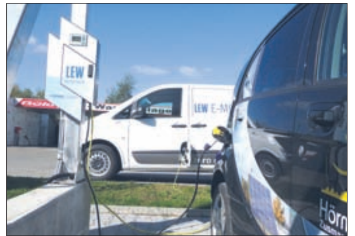
Gespeist wird die Ladesäule von einer Fotovoltaikanlage auf dem Carport der Firma. □
