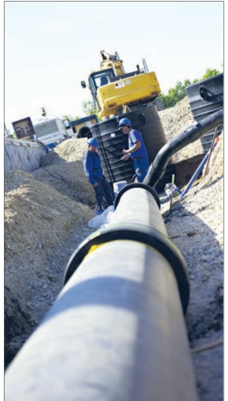
Energieträger Nummer 1 in guten Händen: Neben Erdgasleitungen verlegen „die Blauen“ von Mennicke auch Leitungen für Biogas wie hier für das künftige Bio-Energie-Zentrum von infra fürth.
