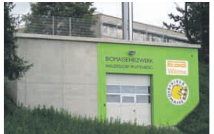
Das Biomasseheizwerk in Mallersdorf-Pfaffenberg von außen. □
