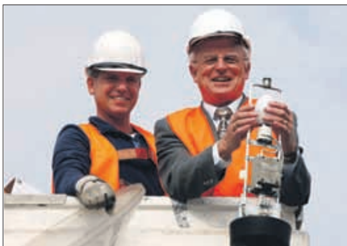
Auftakt zur Umrüstung: Norbert Schwalber, 2. Bürgermeister von Königsbrunn, und LEW-Mitarbeiter Klaus Regner (l.) setzen eine der neuen Energiesparleuchten ein. □
