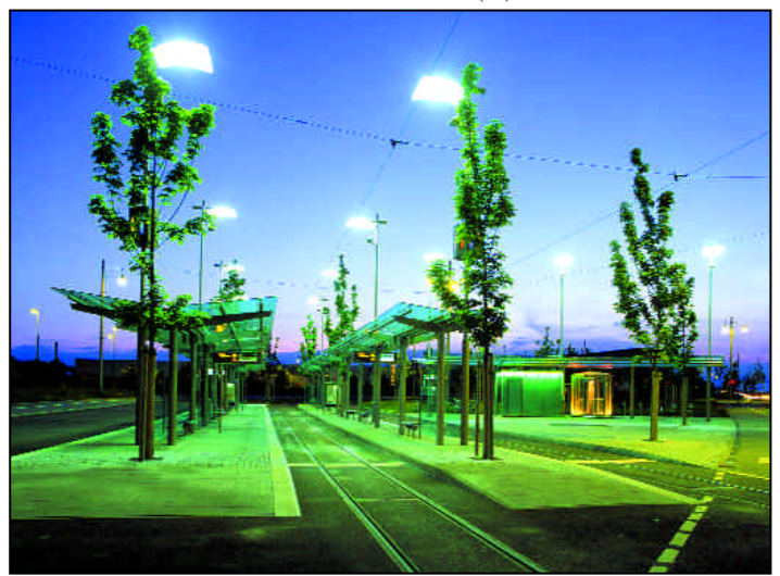
Die NUVOLA-Lichtmasten tauchen die Station in ein angenehmes Licht.
