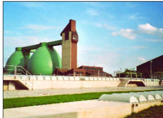
Um Geruchsbelästigungen der Umgebung zu vermeiden, ist die Regensburger Großkläranlage vollständig nach oben und seitwärts abgedeckt. Im Hintergrund befinden sich die 30 m hohen Faultürme. Bild: W. Zeitler
