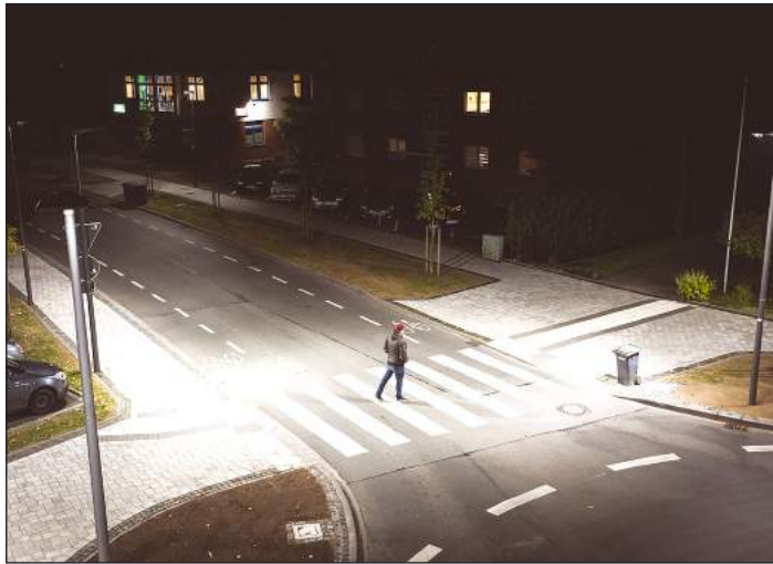
Streetlight 10 Midi Leuchten mit einer speziellen Optik sorgen für eine optimale Ausleuchtung der Fußgängerüberwege.
