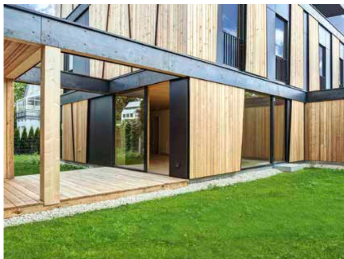
▲ Stahlbänder trennen die einzelnen Geschosse voneinander und verhindern den Brandüberschlag
