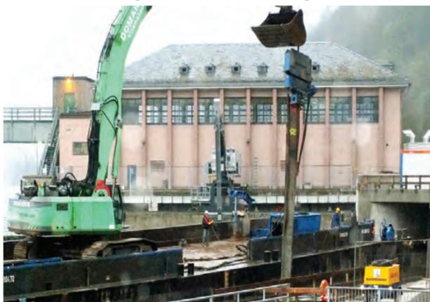
Erweiterungsarbeiten am RMD-Mainkraftwerk Rothenfels auf der Zielgeraden: Vor kurzem wurde mit Hilfe eines Schubboot-Ponton-Verbandes der Reederei Domarin die letzte Spundbohle im Oberwasserbereich gezogen. Sie gehörte zum sogenannten Fangedamm, der die Baugrube für den Turbinenzulauf zum Main hin seit rund zwei Jahren abdichtete. Knapp zwei Monate dauerten die Arbeiten zum Rückbau der Sicherheitseinrichtungen und Abdichtungen für die Baugrube im Oberwasser- und Unterwasserbereich.
