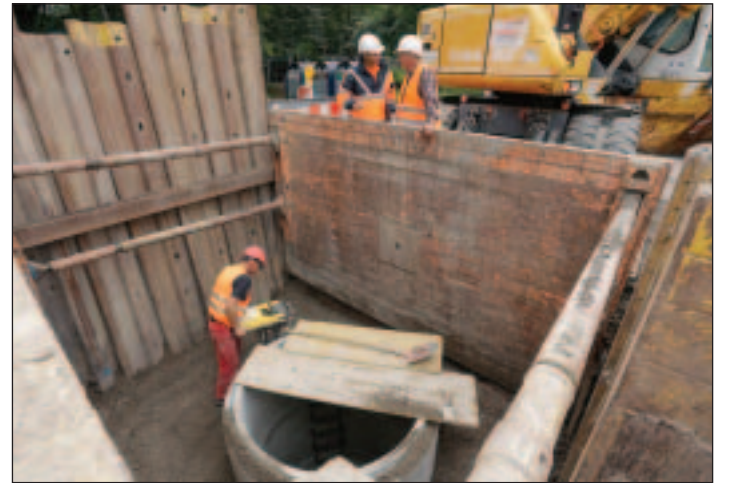
Die vom Güteausschuss der Gütegemeinschaft Kanalbau beauftragten Prüfungingenieure führen derzeit etwa 4.000 Baustellenbesuche pro Jahr durch. Bei diesen unangemeldeten Baustellenbesuchen begutachten sie die Qualifikation und Zuverlässigkeit der Fachfirmen.
