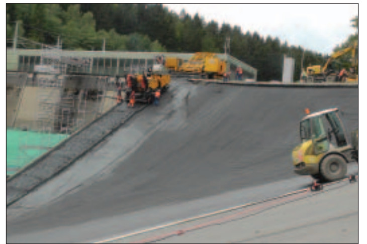
Bahnstrom-Pumpspeicherkraftwerk Langenprozelten Generatoraustausch Maschine 1: Bis kurz vor Weihnachten dauert der komplette Austausch des 84.200 Kilowatt weltweit stärksten Wasserkraft-Einphasen-Motor-Generators (sein Zwillingsbruder wird 2017 ausgetauscht) einschließlich des 245 Tonnen schweren Generatorrotors. Nachdem die beiden äußeren (roten) Gehäusehälften des Generators mit fast sieben Meter Außendurchmesser, jeweils rund drei Meter hoch und 26 Tonnen schwer, bereit getauscht worden sind, werden nun in wochenlangender Handarbeit die insgesamt 3 Meter hohen Blechpakete aufgeschichtet – insgesamt rund 144.000 Bleche à 0,5 mm dick. Die Rotorwelle kommt im Herbst 2015 per Spezialtransport über die Alpen. Bild: Jan Kiver, RMD AG
