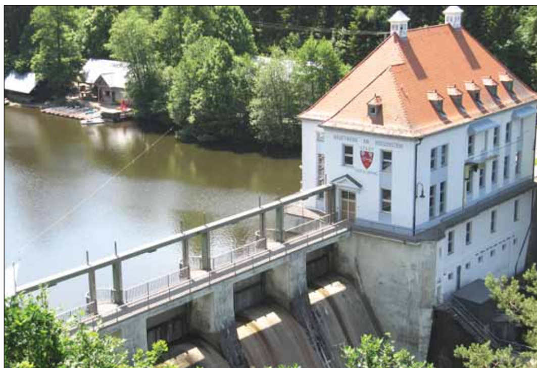
Ein einmaliges Projekt ist die Druckkammer-Fischschleuse im Kraftwerk am Höllenstein im Bayerischen Wald. Bild: DK
