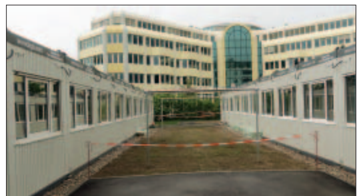
Die Containeranlage besteht aus drei einzelnen Riegeln. Insgesamt finden hier 86 Personen eine Unterkunft.
