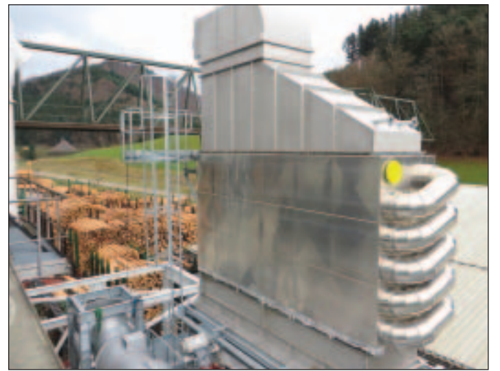
Effizienzsteigerung bis zu 25 Prozent: Die neue Rauchgaskondensationsanlage am Holzwerk Dold.
