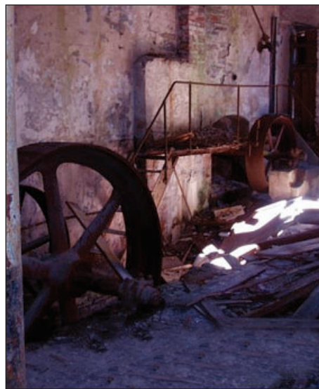
Eine denkmalgeschützte Wasserkraftanlage. Die Politik ist gefordert! Bild: Müller
