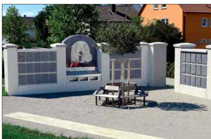
Standard-Urnenwände von Paul Wolff mit individuell gefertigten Teilen von einem Bildhauer und einer Schlosserei vor Ort.
