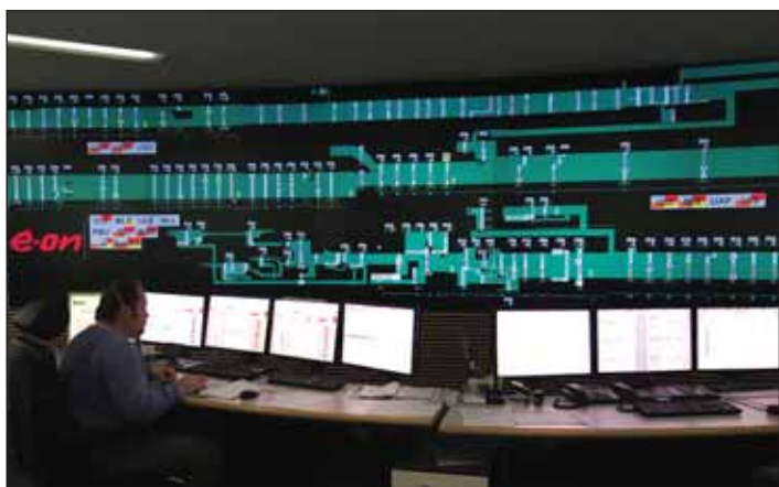
Besuch der Zentralwarte von E.ON Wasserkraft in Landshut.
