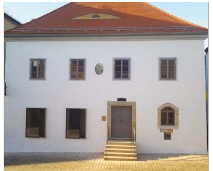
Die sanierte „Bauhütte“ dient als zentrale Anlaufstelle für die Markt-gemeinde Perlesreut und die Ilzer Land Gemeinden. □
