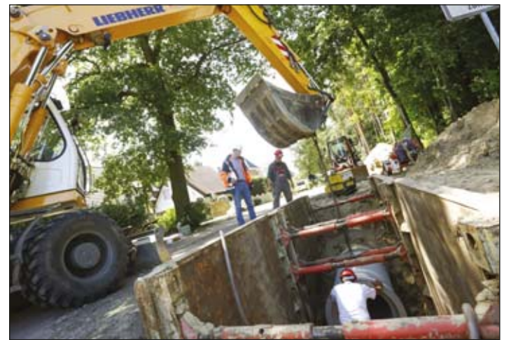
Unterwegs in Sachen Qualität: Die vom Güteausschuss der Gütegemeinschaft Kanalbau beauftragten Prüflingenieure führen derzeit etwa 4.000 Baustellenbesuche pro Jahr durch. Bild: Güteschutz Kanalbau
