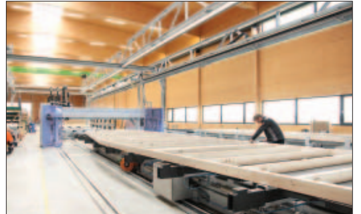
Vorfertigung im Zimmerer- und Holzbaubetrieb. Bild: Sascha Schneider/Landesinnungsverband des Bayerischen Zimmererhandwerks.
