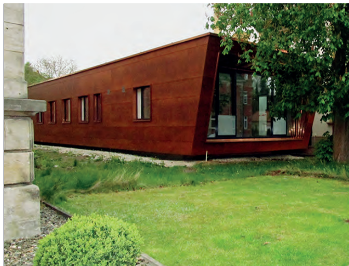
In kurzer Zeit ließ sich der auf die Bedürfnisse der Mitarbeiter zugeschnittene Holzrahmenbau errichten. Bild: Staatliches Bauamt Bamberg
