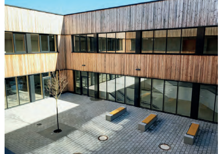
Schön und modern: der Neubau der Carl-Steinmeier-Mittelschule Hohenbrunn.
