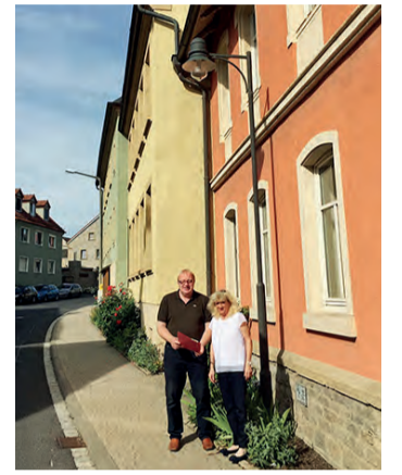
Bürgermeisterin Martina Rottmann und Jürgen Lang begutachten die neue LED-Beleuchtung.
