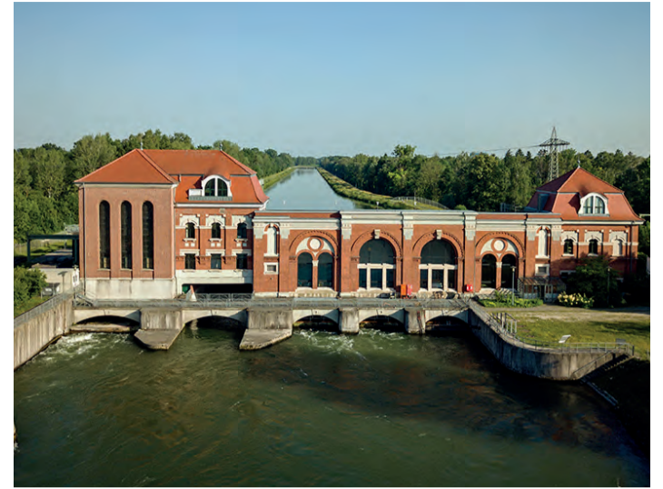
Das Wasserkraftwerk Langweid.
