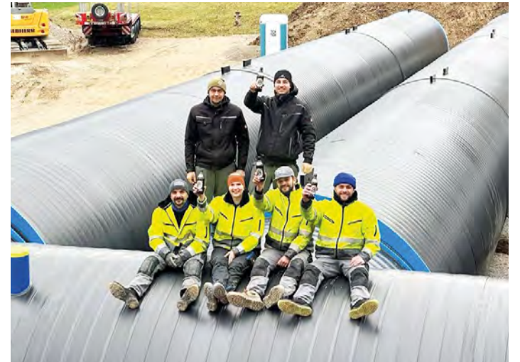
Zufriedener Montage-Trupp der Freilassing Firma Hawle nach dem erfolgreichen Abschluss der Schweißarbeiten am Tenglinger Röhrenspeicher am 10. November 2023. Bild: Michael Obermeier/Achengruppe, 2023
