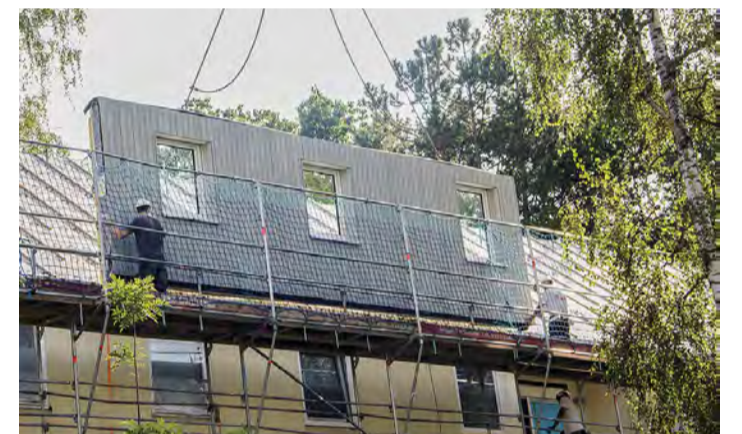
Seriell Sanieren Reinerzer Straße 52-54.
