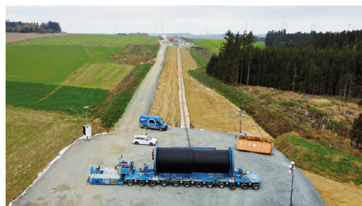
Erdkabeleinzug von Kabeltrommel in Muffengrube.
