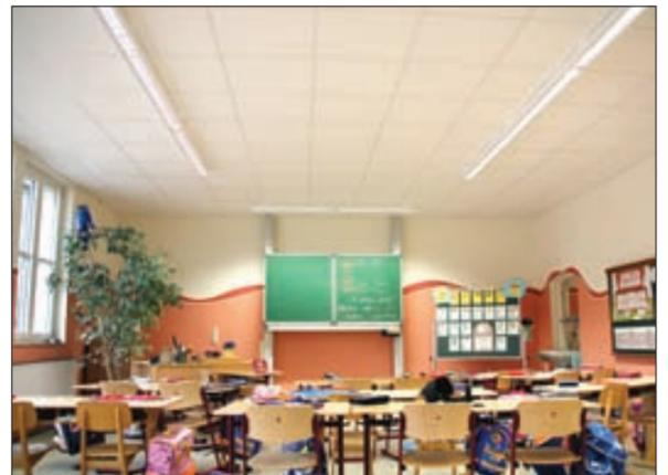
Cubus-Spiegelrasterleuchten von Regiolux mit elektronischen Vorschaltgeräten und Leuchtmitteln der EU-Effizienzklasse A sorgen in Kombination mit einer tageslichtabhängigen Beleuchtungssteuerung für optimales Licht und mindestens 60 Prozent weniger Stromverbrauch. Foto: Gemeinde Edelsfeld
