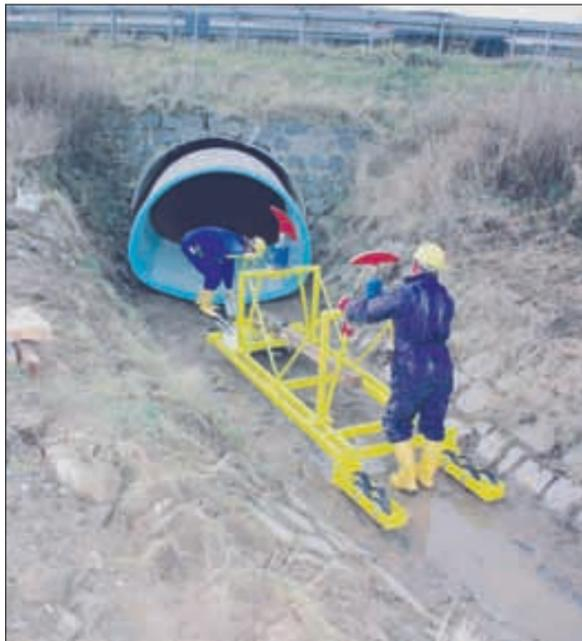
Mit modifizierten Arbeitsschritten und speziell von D&S entwickelten Werkzeugen lässt sich das Montageverfahren noch schneller und flexibler anwenden. Foto: Diringer & Scheidel
