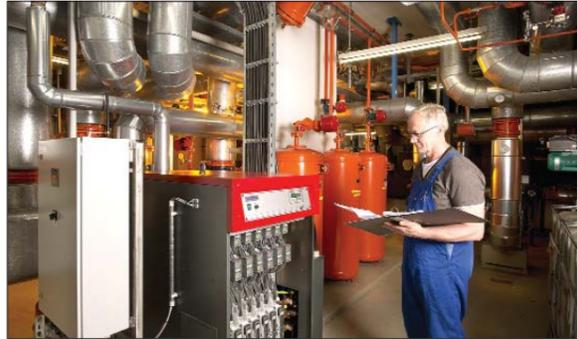
WVS-Mitarbeiter Erwin Hüb in der Heizzentrale Königsbrunn: Die sogenannte Power-to-Heat-Anlage ermöglicht es, überschüssigen Strom für die Wärmeerzeugung zu nutzen und damit das Stromnetz zu stabilisieren. Bild: LEW/Wolfgang Müller
