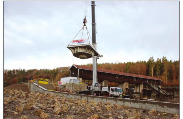
Langsam wird die Turbine über den Montageort am Wehr in Baierbrunn geschwenkt.
