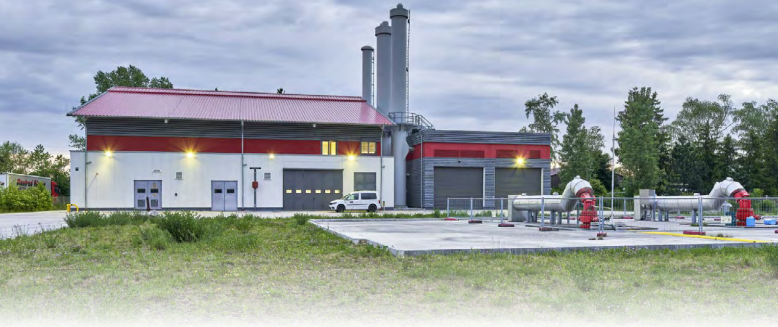
Energiezentrale der WVI GmbH &amp; Co.KG
