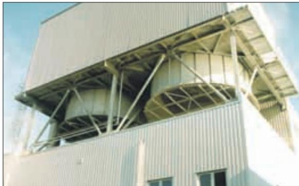
Die beiden Luftkondensatoren haben die Aufgabe, den Dampf nach seiner Nutzung in der Turbine herunterzukühlen. Der Dampf kondensiert zu Wasser und wird dann im geschlossenen Wasserkreislauf zurück in den Dampfkessel geleitet. Je leistungsfähiger die beiden Ventilatoren sind, je höher ist der Wirkungsgrad der Turbine.
