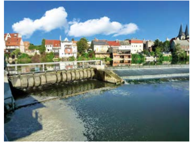
Die Wasserkraft-Technologie ist seit über 100 Jahren erprobt und bewährt.
