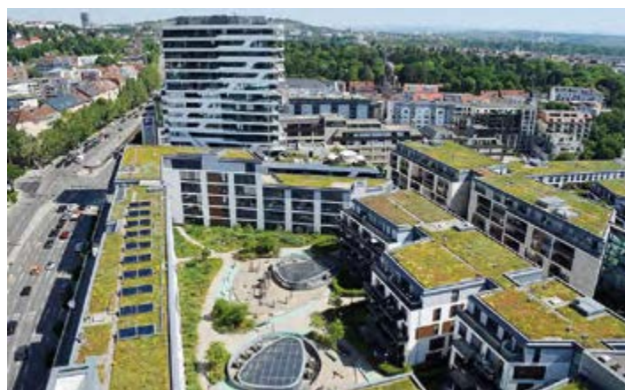
Gebäudebegrünung mit PV-Modulen.
