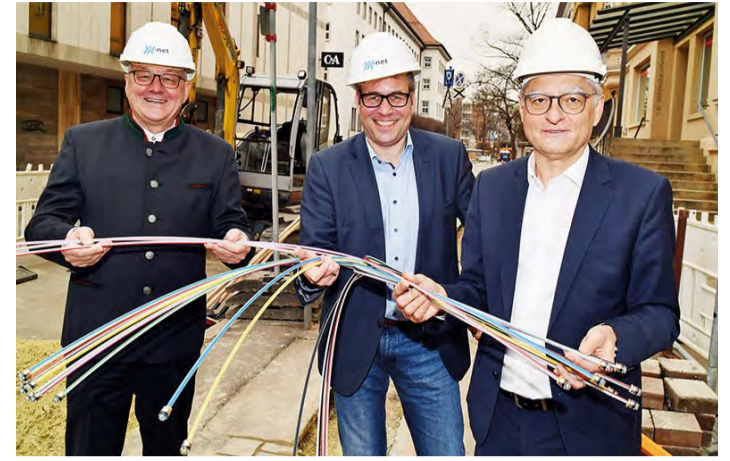
Der Technische Geschäftsführer von M-net, Dr. Hermann Rodler, Augsburgs Wirtschaftsreferent Dr. Wolfgang Hübschle und swa Geschäftsführer Alfred Müllner (v.l.) starteten 2022 den Glasfaserausbau von weiteren 4.000 Haushalten in 600 Gebäuden.
